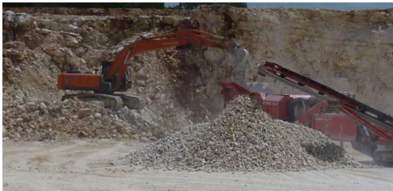
Le chargement de la trémie du groupe mobile par la pelle
