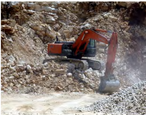
Reprise du tout venant à la pelle, en pied de front
