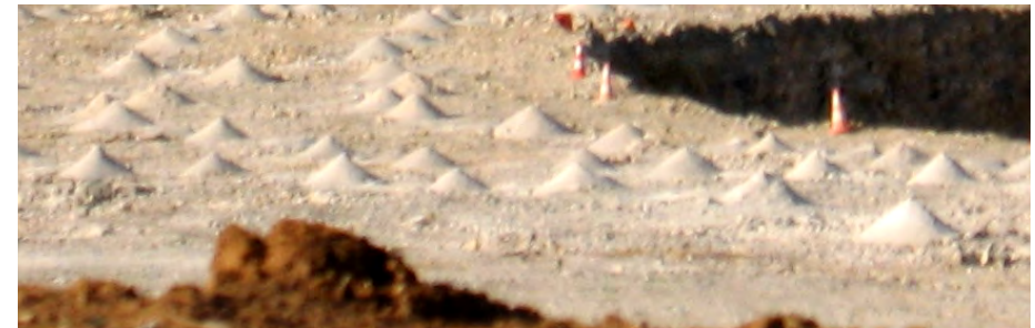
Trous de mines en vue d'un tir ▲
