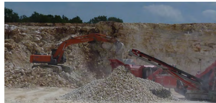
L'alimentation de la trémie du concasseur par la pelle hydraulique ▲
