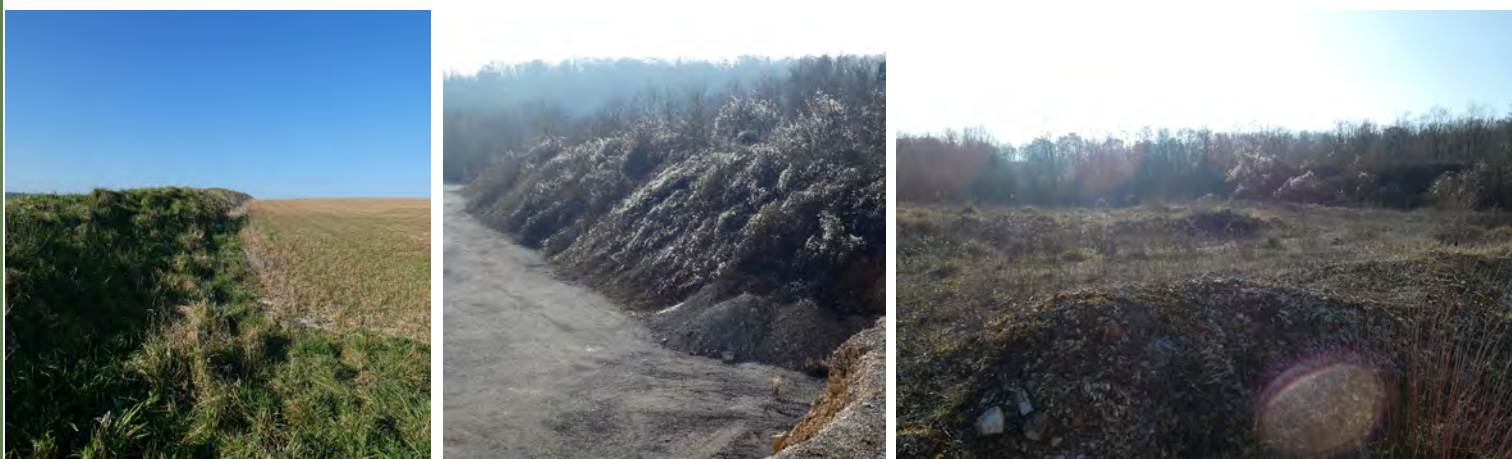
▲ Le merlon de terre végétale en bordure de la zone décapée, le front taluté en limite ouest et la zone de dépôt au sud
