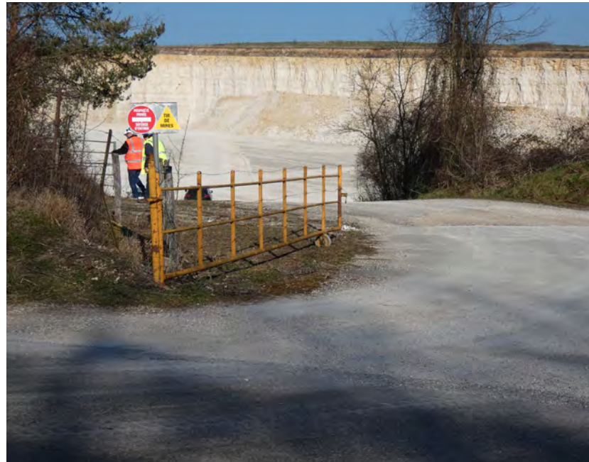
▲ Portail installé à l'accès à la carrière
