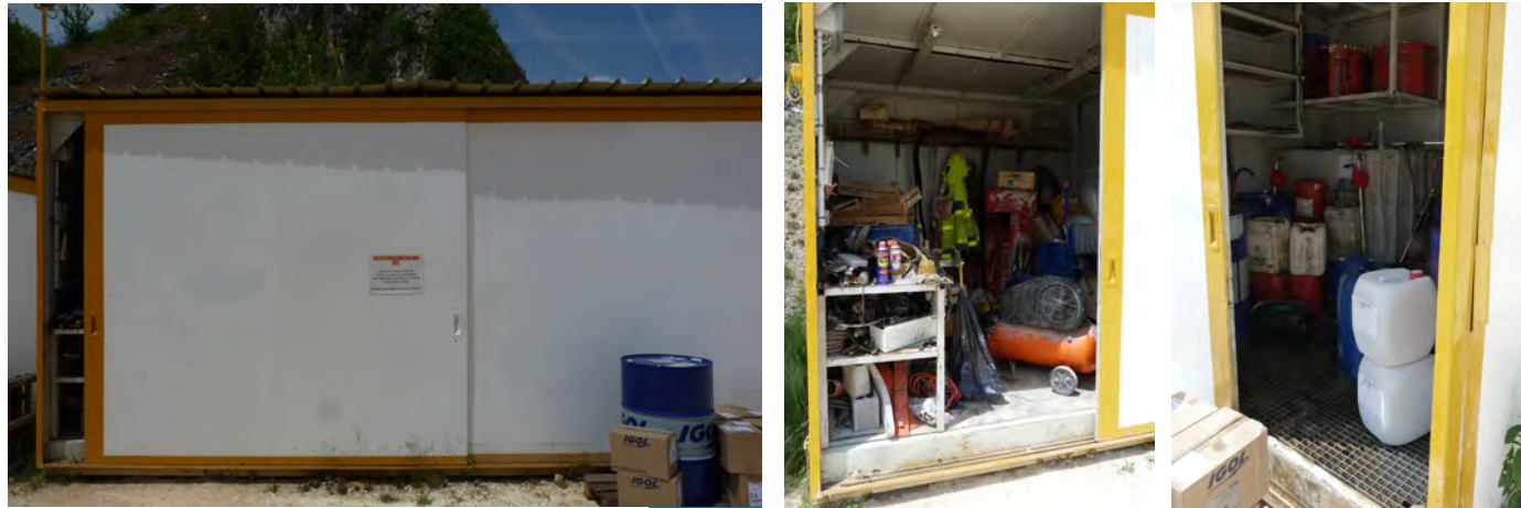
▲ Exemple de container technique
