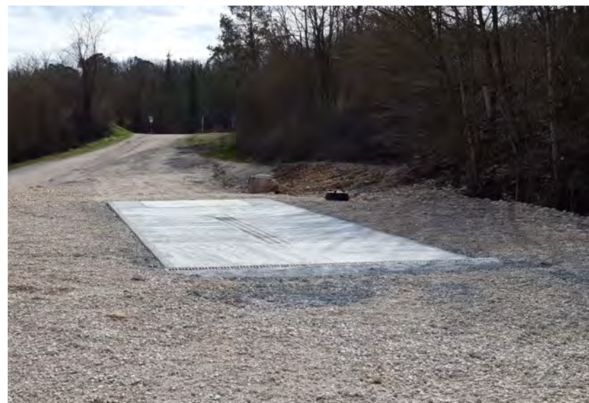
▲ L'aire étanche sur le site
