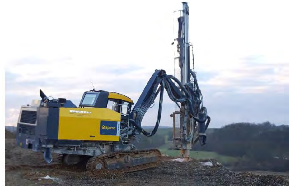
Foration des trous de mines, vue générale de la perforatrice et détail ▲
